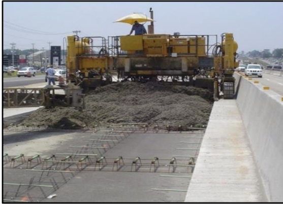
Рисунок I-4-1. Шви розширення у цементобетонному покритті
