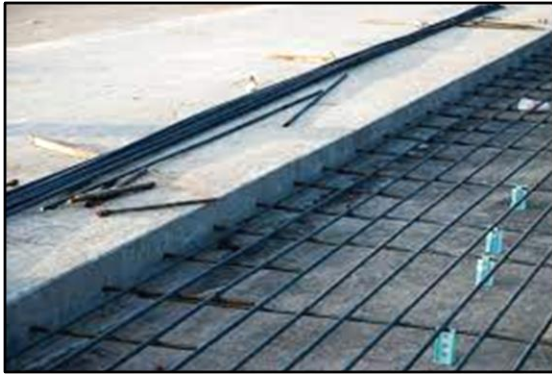
Рисунок I-3-1. Влаштування поздовжнього суміжного шва стискання
