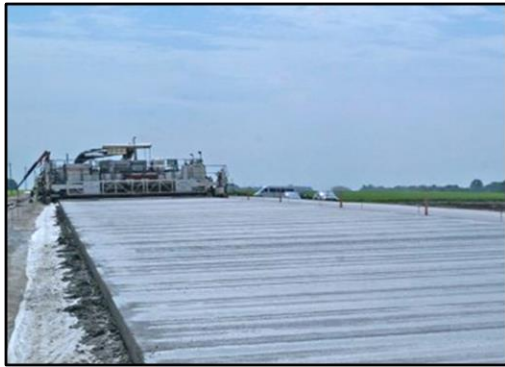
Рисунок I-1-1. Бетонування цементобетонного покриття з добавкою в бетон Penetron Admix
