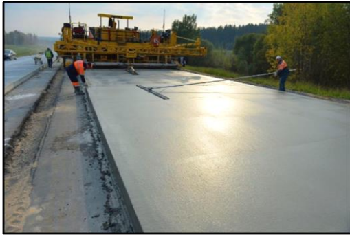
Рисунок I-5-1. Технологічний зазор між двома смугами бетонування для подальшого влаштування основи дорожнього огороження парапетного типу
