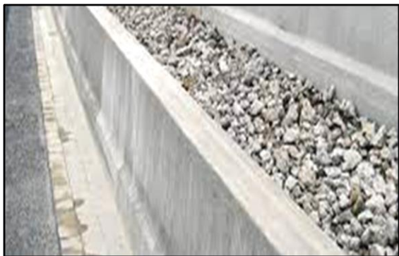
Рисунок I-8-1. Монолітне дорожнє огороження парапетного типу
