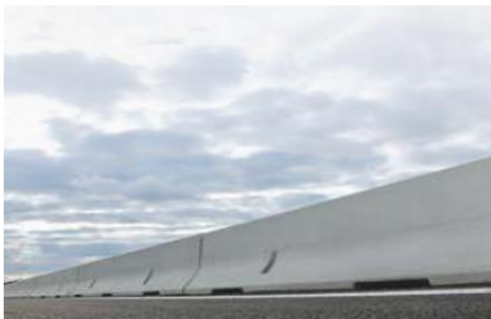
Рисунок I-6-1. Установка збірних залізобетонних дорожніх огорожень парапетного типу в проектне положення
