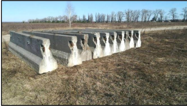
Рисунок III-1-1. Демонтовані парапетні блоки огороження типу Нью-Джерсі, які рекомендовані для відновлення та подальшого повторного використання
