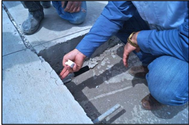
Рисунок II-1-1. Новий шар цементобетонного покриття при підсиленні жорсткого дорожнього одягу
