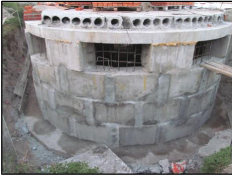
Рисунок I-9-1. Улаштування гідроізоляції стиків збірних елементів
