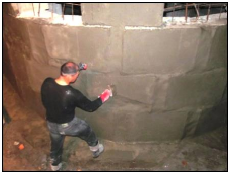
Рисунок I-9-2. Улаштування гідроізоляції зовнішньої поверхні збірних елементів
