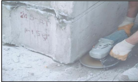
Рисунок II-2-1. Підготовка штроб для гідроізоляції збірних конструкцій
