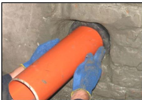
Рисунок П-4-2. Улаштування нової гідроізоляції місць вводу комунікацій
