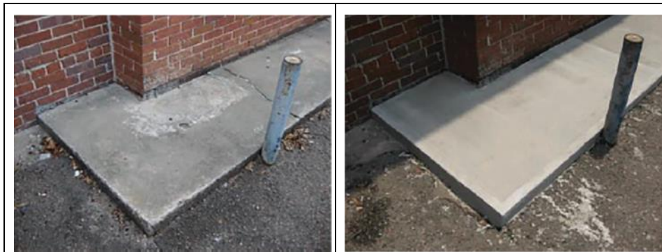
а) б) Рисунок 1 – Бетон, відновлений Renew CR: а) до нанесення; б) після нанесення
