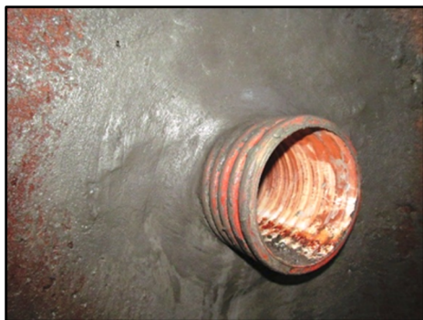
Рисунок I-5-1. Монтаж комунікаційної труби з гільзою типу «бетон-гільза»
