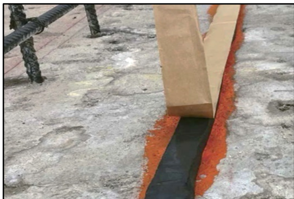
Рисунок I-2. Монтаж бентонітового джгута Penebar вздовж шва бетонування
