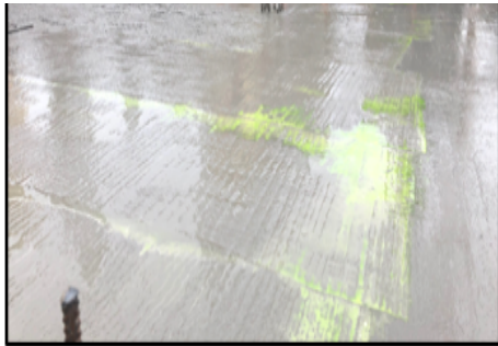
Рисунок II-1-1. Улаштування гідроізоляції плити
